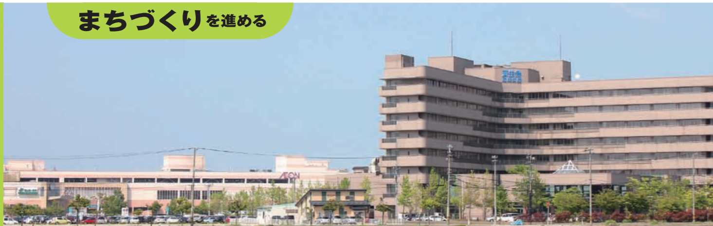
〈富山〉高岡病院と、隣接するイオンモール高岡(左)。高岡病院、市、イオンモールの3者が協力してまちづくりを進める
