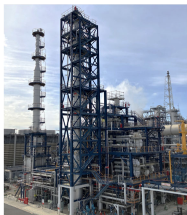
完工したSAF製造設備 （コスモ石油堺製油所構内）
